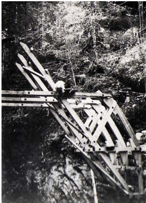
Costruzione della centinatura sul lato opposto (foto, sinistra). Posa delle pietre con l'ausilio del «pescante». Le pietre venivano lavorate a lato, poi prese, sollevate, girate e calate dove necessitavano (foto, destra)
