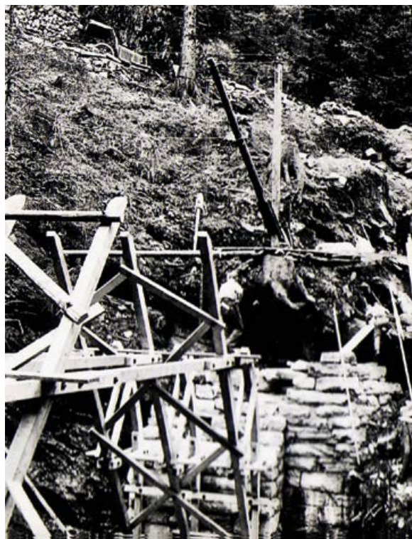
Costruzione della centinatura sul lato opposto (foto, sinistra). Posa delle pietre con l'ausilio del «pescante». Le pietre venivano lavorate a lato, poi prese, sollevate, girate e calate dove necessitavano (foto, destra)
