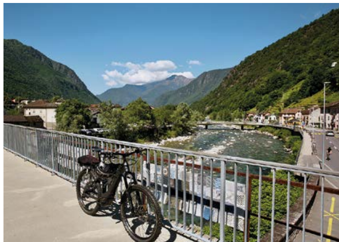
Passaggio della Moesa sul vecchio ponte ferroviario a Roveredo. Foto: Lino Succetti
