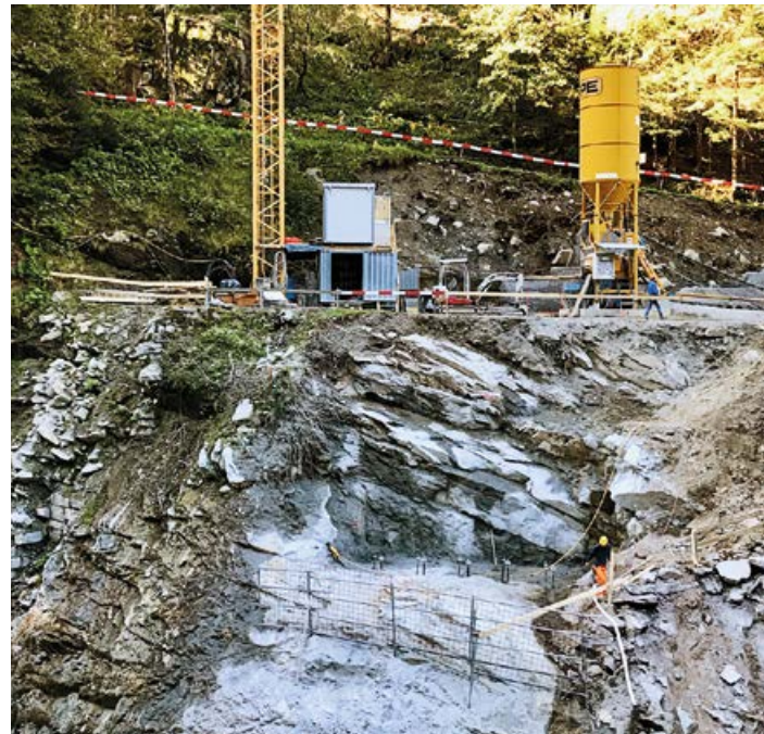
«Scarpa» nella roccia per l'appoggio della fondazione verso Bondo. Sopra: l'impianto del calcestruzzo e la gru (2019)
