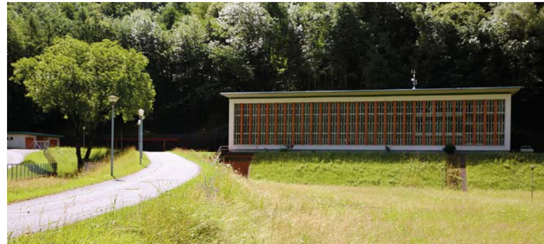
Centale ELIN di Lostallo, 2 bell'esempio di edificio industriale anche di valore architettonico. Costruzione a pianta rettangolare con facciata scandita dall'alternarsi di pilastri in rosso e vetrate con tetto piano aggettante. Costruita nel 1958 dall'ingegner Giovanni Lombardi, su un progetto dell'architetto, pittore e designer Carlo Basilico. Foto: Lino Succetti 2021
