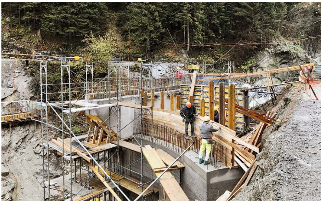
Armatura curva per l'invito dalla strada al ponte nella parte superiore dell'appoggio del ponte
