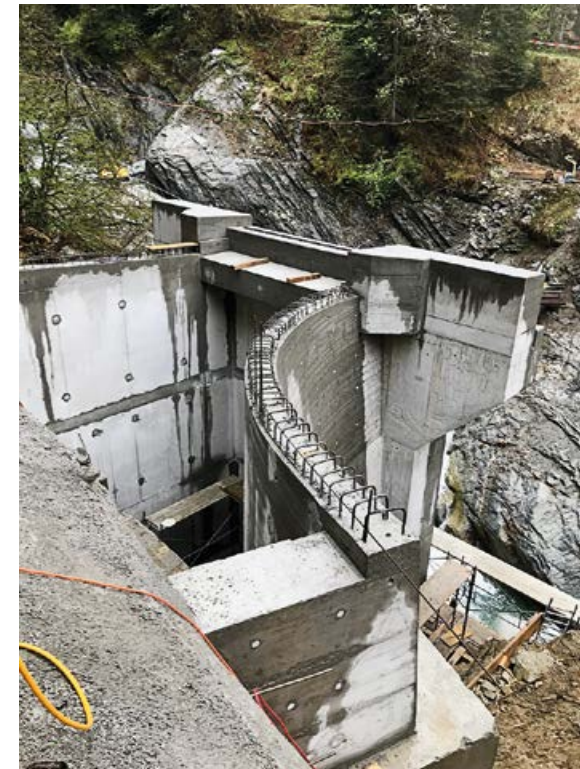
La forma geometrica assai complicata da realizzare con il calcestruzzo, prima del riempimento interno (lato Mota)
