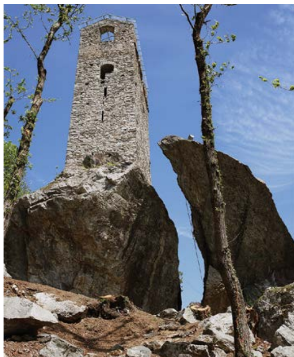
La Torre di Pala a San Vittore, scattata nel mese di aprile 2019 al termine dei lavori di taglio e potatura degli alberi e pulitura del terreno adiacente la torre, interventi che permettono ora di ammirare meglio la torre e i maestosi macigni rocciosi su cui è stata edificata o che la circondano. Foto: Lino Succetti
