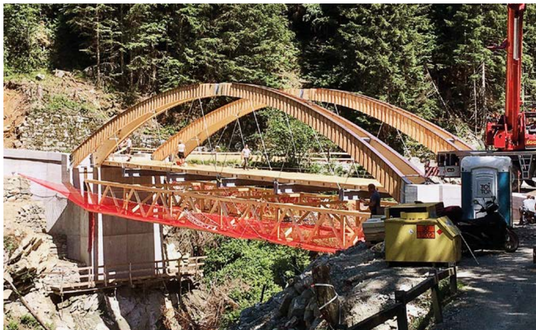
Il nuovo ponte durante la posa degli archi in legno
