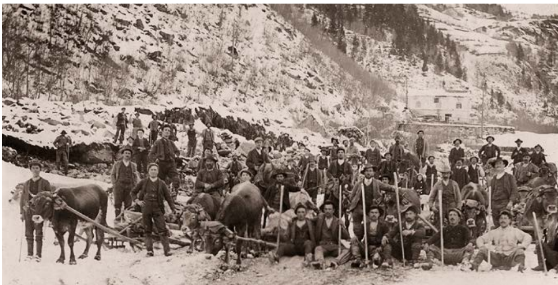
Estrazione di pietre in zona Burin, presso Li Curt, utilizzate per la manutenzione degli argini del fiume, le cosiddette muladi, da parte di una squadra di uomini durante l'inverno 1911-1912. I sassi erano trasportati su slitte trainate da mucche. © Archivi fotografici della Valposchiavo • ISTORIA
