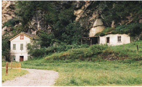
Gli stessi crotti: ben visibili i muri di sostegno e il tracciato dell'antica strada di valle, anticamente detta anche Strada Imperiale. La saletta al piano superiore del crotto 2 (con la croce svizzera) era adibita a luogo di rappresentanza e di svago. Foto: Remo Tosio
