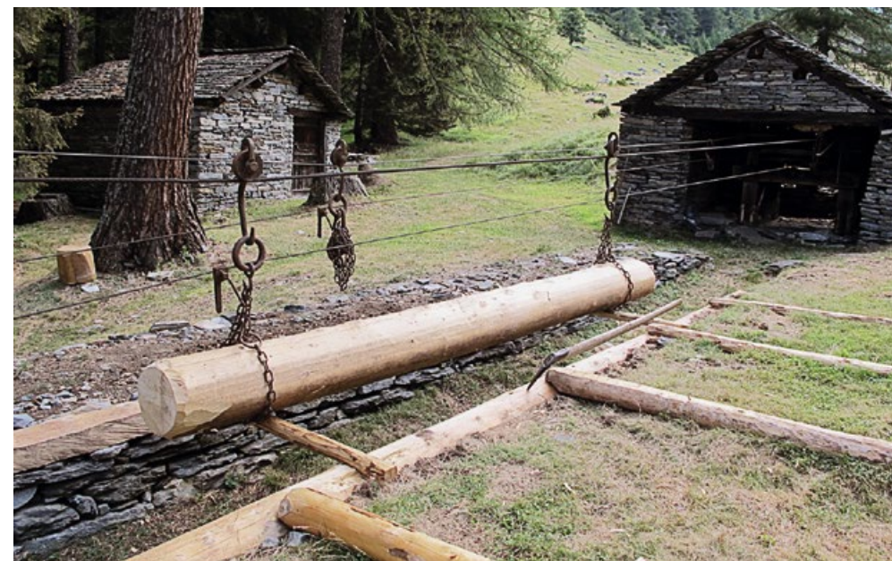
Ricostruzione eseguita da Adriano Rizzi della partenza del filo a freno a Crastèira, Valle della Forcola. Foto: Luciano Mantovani, dal DVD Boràtt, Documentario sul lavoro e sulla dura vita dei boràtt (boscaioli) nella valle della Forcola a Soazza negli anni 1937–1961
