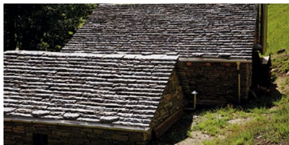
I tetti sono stati rimossi e sostituiti da una nuova copertura con legname della zona e piode in parte recuperate dalla vecchia copertura e in parte provenienti da Arvigo in Calanca
