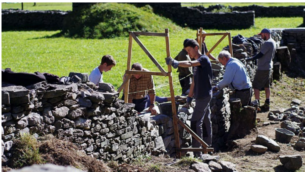
Corso per la costruzione dei muri a secco
