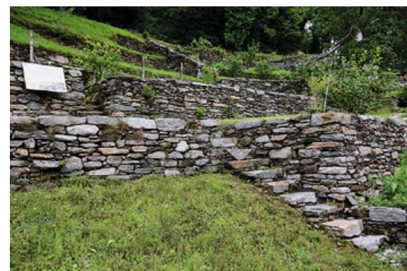
Sotto: Sistemazione del versante montano con muri in pietra a secco a filo del piano d'uso, nella zona appena sovrastante i vecchi edifici ristrutturati a «La Vila». Foto: Lino Succetti
