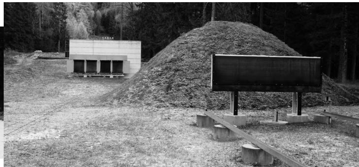
Casse parapalle a 50 m con muro di protezione e cassa parapalle a 25 m
