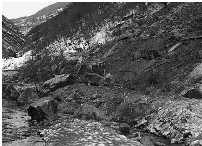
Vista dal ponte di Buseno verso nord: coperti dalla massa franosa il greto del fiume Calancasca, l'accesso alla centralina elettrica collocata nello stabile a sinistra nell'immagine, la strada dal/per Buseno e in alto la strada di valle
