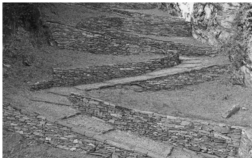
I tornanti del Gardanèll. Foto: di Paolo Mantovani
