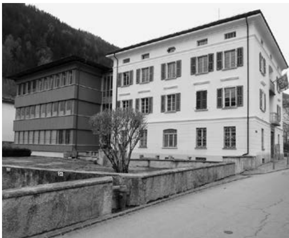
"Ca da Cumün" di Poschiavo, ampliamento realizzato dallo Studio di architettura Gervasi & Wyss, 1997
