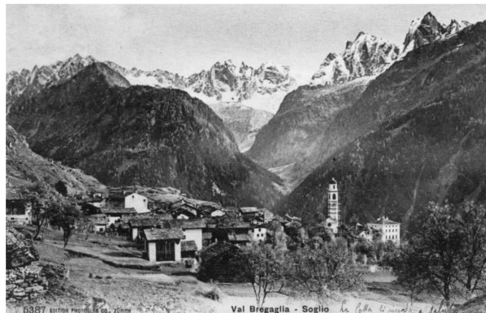
Soglio, cartolina viaggiata nel 1911 e realizzata durante i lavori di inizio 900
