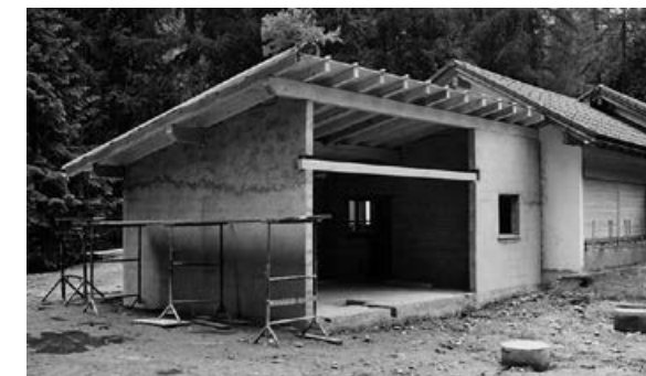
Costruzione del poligono 25 m estate 2001
