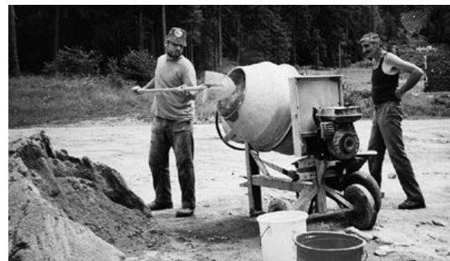
(Foto sopra e sotto) costruzione del poligono 100/50 m a Dree Mota, estate 1994
