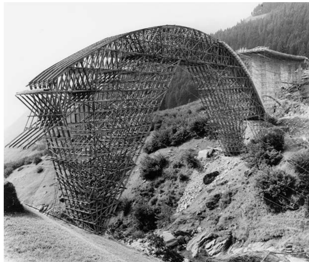
Costruzione ponte N13
