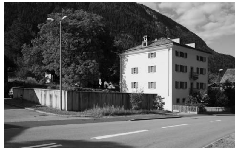
Cortile privato con posteggi coperti, Stampa, Arch. Rodolfo Fasciati, Stampa, 2006. Foto: James Batten/Schweizer Heimatschutz
