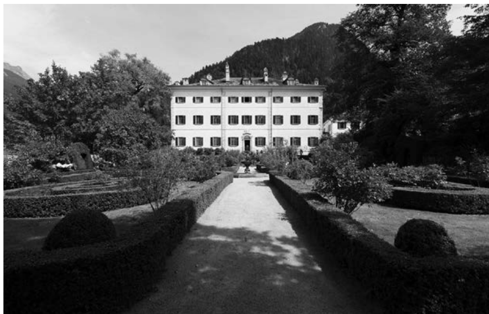
Palazzo Salis, Bondo, Arch. Francesco Croce, 1766–1775, restaurato esternamente nel 1997–1998, manutenzione del giardino, Jane Bihl-de Salis, architetto paesaggista, dal 1991. Foto: James Batten/Schweizer Heimatschutz
