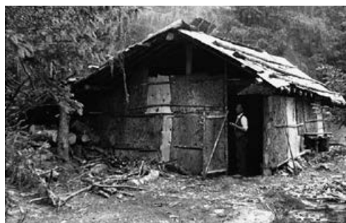
In «Borátt 1» si parla anche delle baite costruite con tronchi e ricoperte interamente con grandi superfici di corteccia
