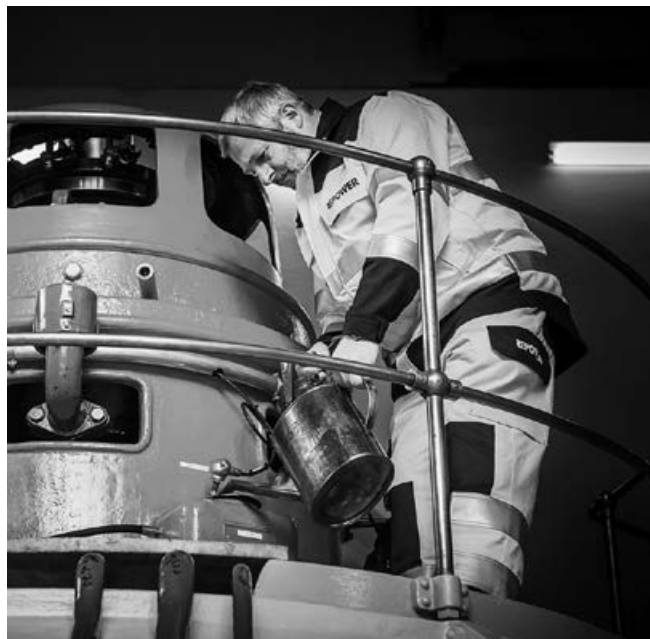
Daniele Mazzucchi nel suo lavoro di manutenzione del generatore di Cavaglia
