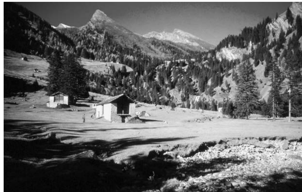
Corina, prima dei lavori delle forze idriche
