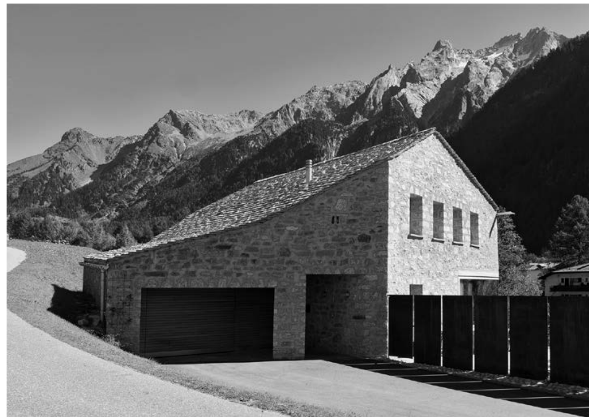
Casa nuova, Al Sasc, Vicosoprano, Arch. Renato Maurizio Maloggia, 2011–12. Foto: Arch. Renato Maurizio, Maloggia
