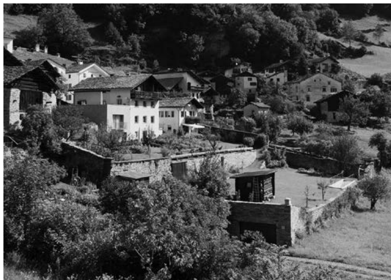
Autorimessa sotterranea sotto il giardino, Soglio, Ing. Martin Gini, Bivio e Maloggia, 2011. Foto: James Batten/Schweizer Heimatschutz
