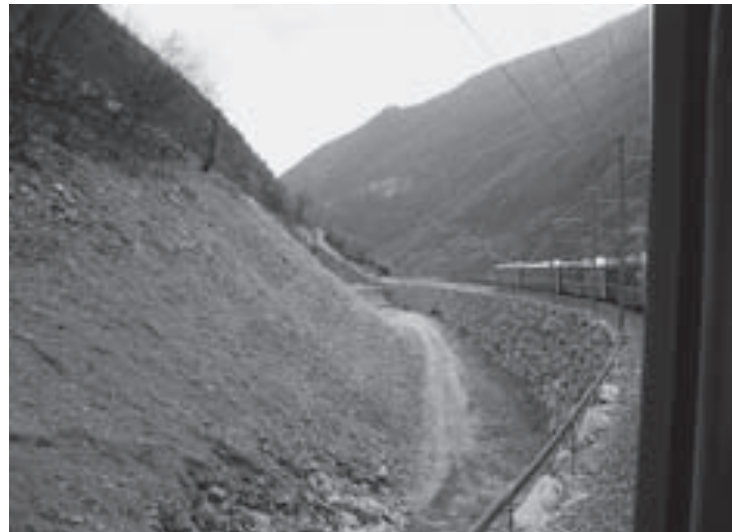
Giorno 4 aprile 2009: Il Bernina-Express può raggiungere nuovamente la stazione di Tirano. Panoramica del vallo di protezione ultimato. Il sedime ferroviario è stato spostato a valle
