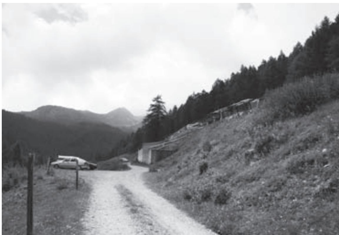
L'alpe Pescia Basa: abitazione dell'Alpeggiatore, struttura per la lavorazione del latte e piccola stalla
