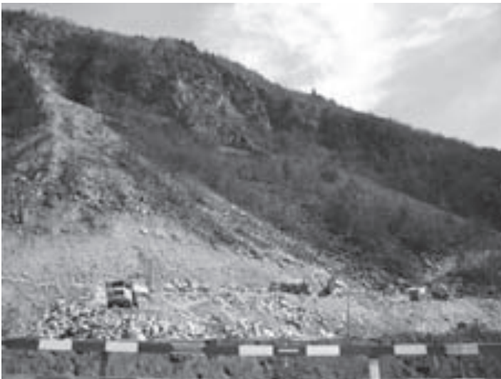
Vista del cantiere durante i lavori di costruzione
