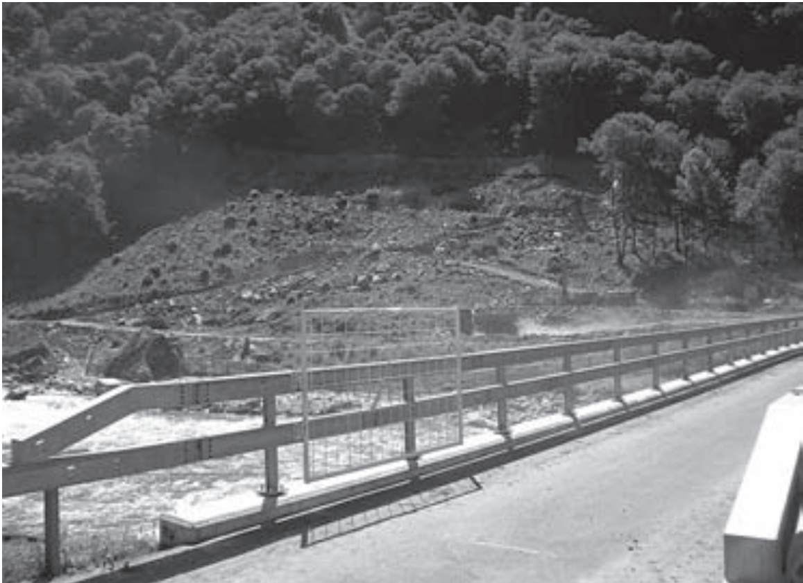
Lavori preparativi al portale est della galleria con il ponte di cantiere
