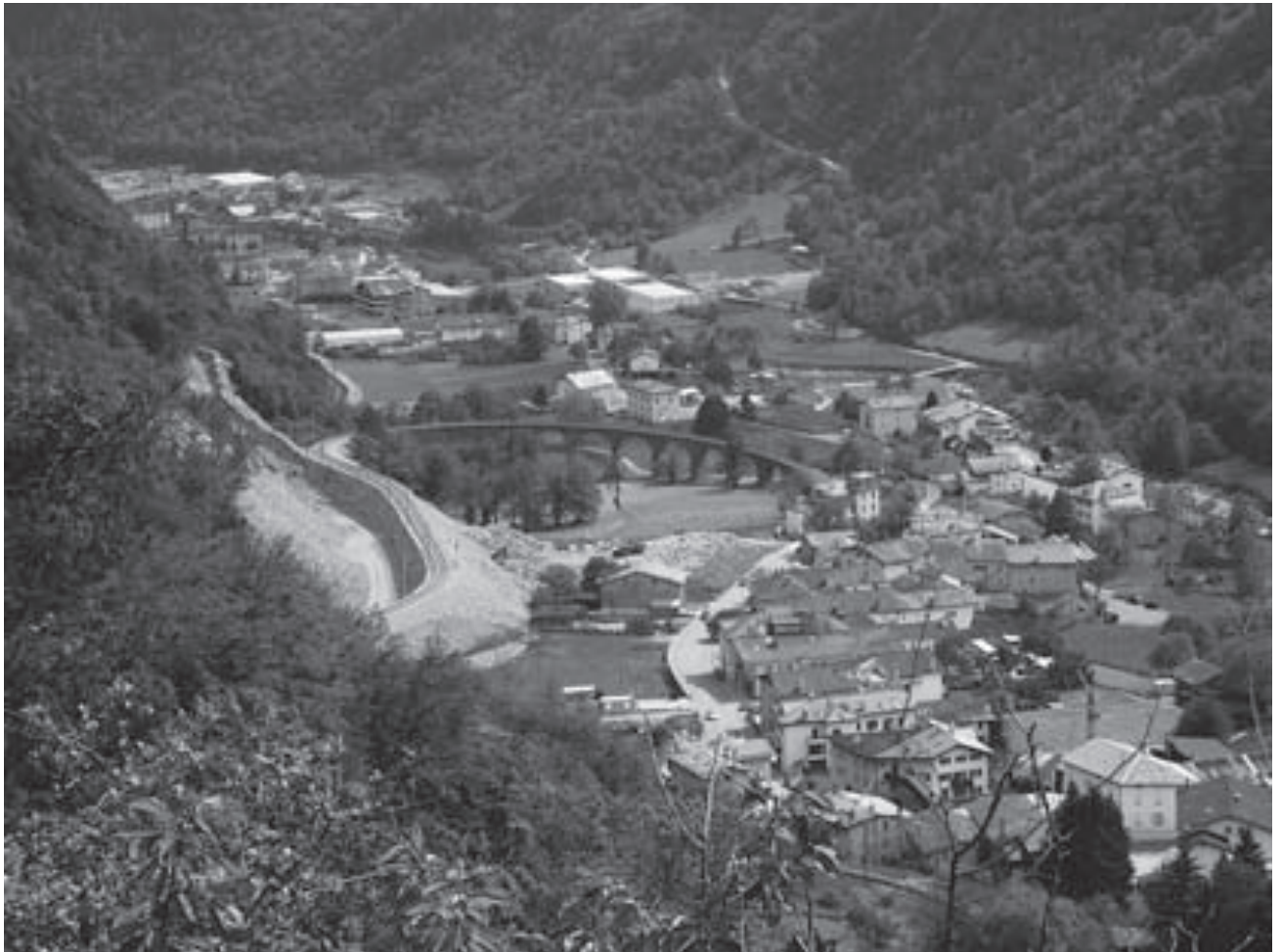
Panoramica dell'opera ultimata, vista dalla strada di Viano
