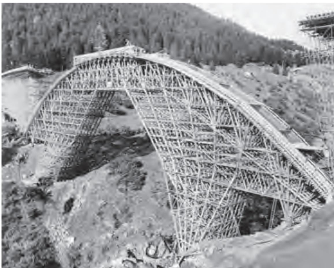
**Impalcatura per la costruzione del viadotto A13 di Nanin, fra Mesocco e Pian San Giacomo, (seconda metà anni '60)**
