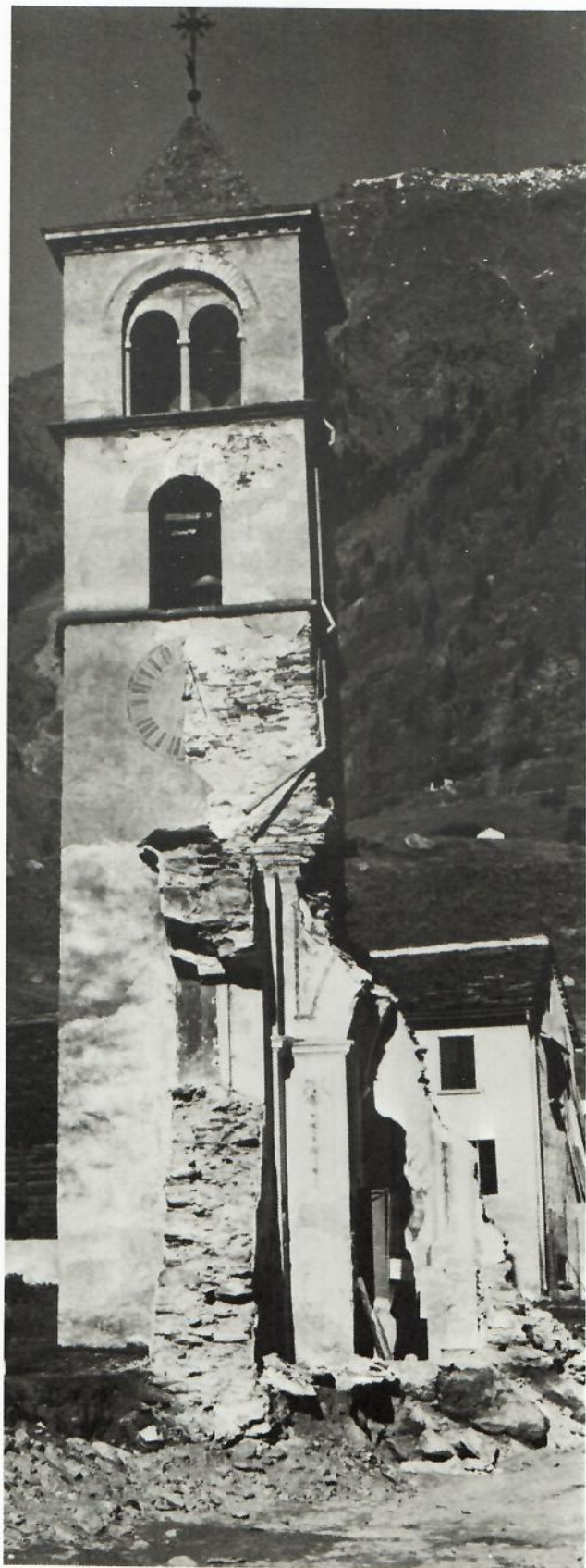
Campanile della chiesa di Cebbia, distrutta dall'alluvione dello scorso mese di agosto.
