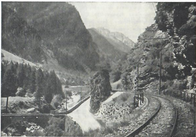
Ponte del Sasso sotto Soazza
