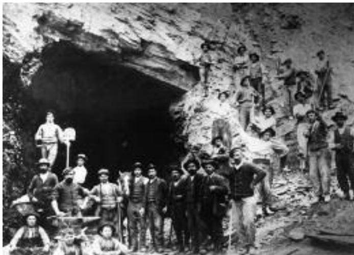
Operai della ferrovia del Bernina. (Archivio fotografico Luigi Gisepp / Società Storica Val Poschiavo)
